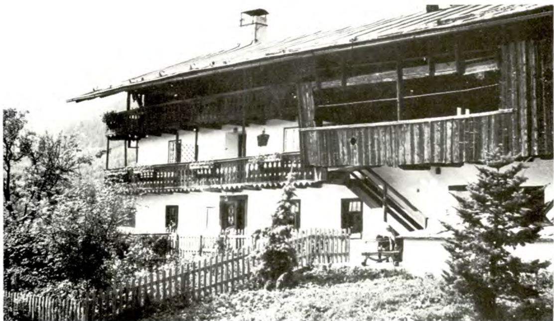
Abb. 2: Einhof mit traufseitig erschlossenem Mittelflur, Chiave, Zustand 1977, im Vorjahr abgebrannt.
