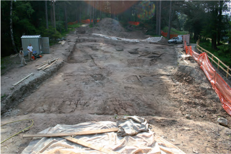
Fig. 26: OCF 2005: Panoramica dell'area indagata
