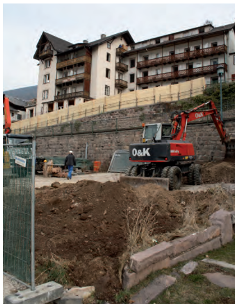
Fig. 17: OHA 2008: L'area di scavo 2008 all'inizio dei lavori. Sullo sfondo, l'ex Hotel Regina
