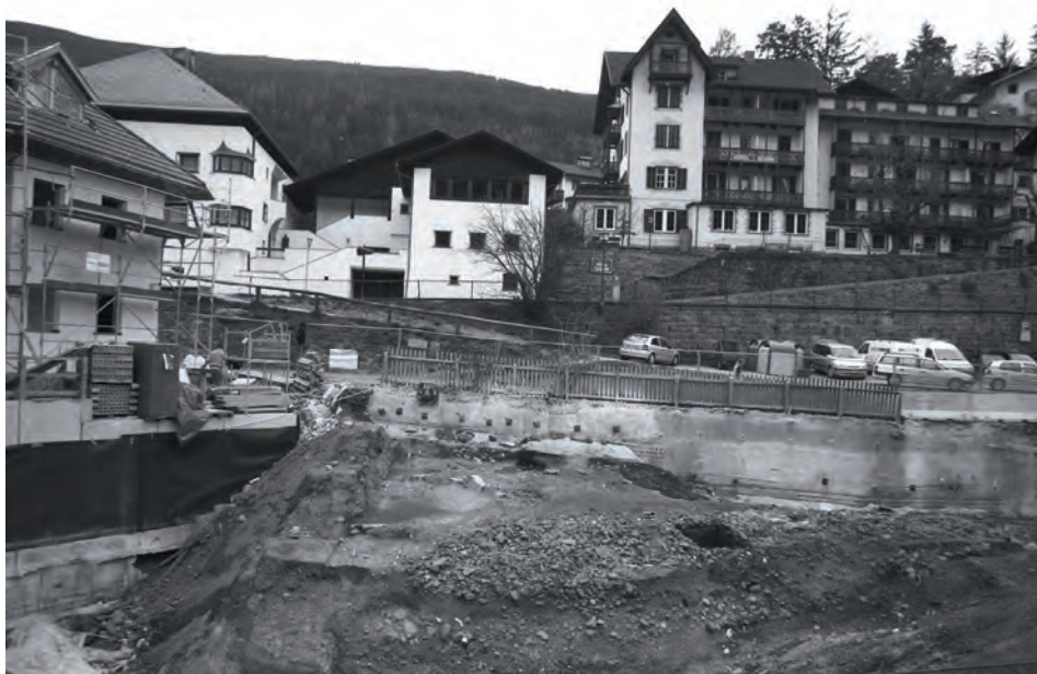
Fig. 3: OHA 2005: Panoramica dell'area di scavo 2008
