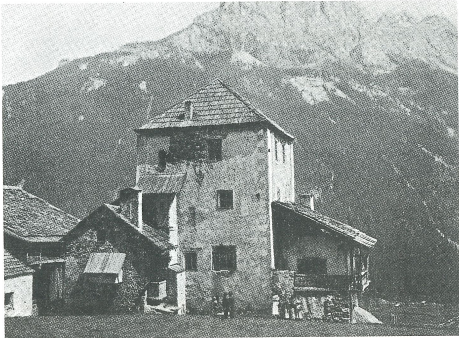
Altes Gerichtshaus in Vigo di Fassa.
